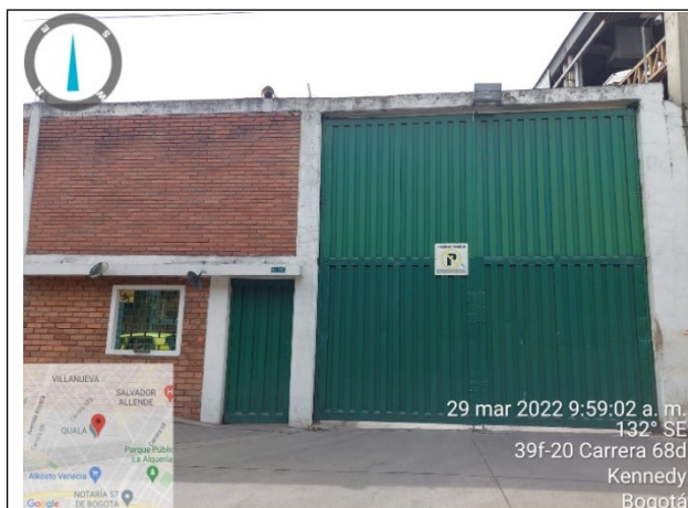
Fotografía No. 1. Fachada del predio.
